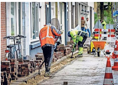
Het aanleggen van glasvezel in een straat in Rotterdam. FOTO ANP/HH
